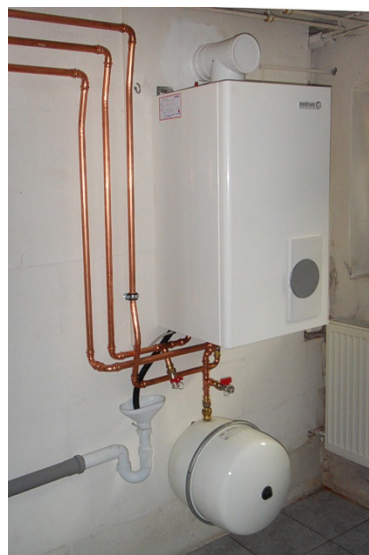
neue Heizung für das Wohnhaus
